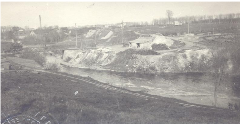
Four à chaux et carrière du Pont des Dalles
